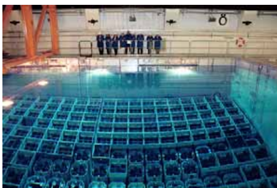
CLAB の使用済燃料の貯蔵プール
