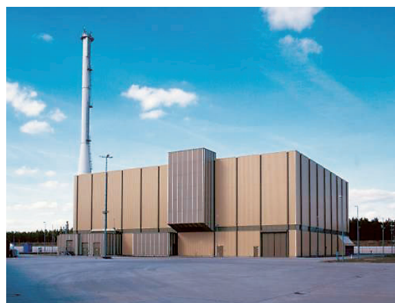
使用済燃料のパイロット・コンディショニング施設 (1999年にゴアレーベンに建設) Pilot-Konditionierungsanlage (PKA)
