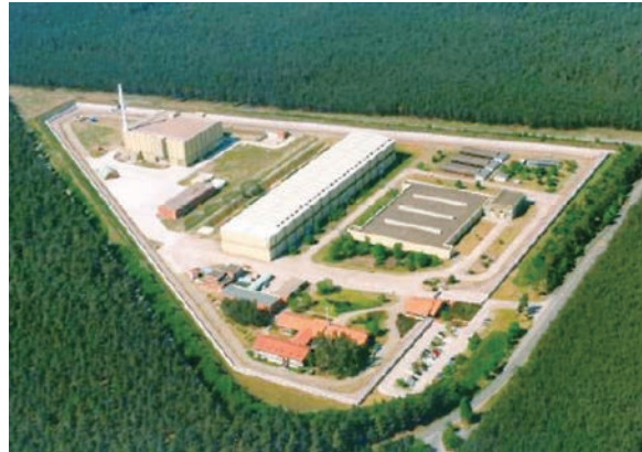
ゴアレーベンの中間貯蔵施設
