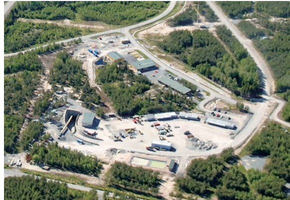
ONKALO®の建設状況（2006年夏頃）
