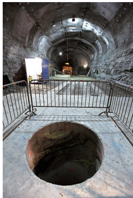
オルキルトの地下特性調査施設内の坑道と試験処分孔
