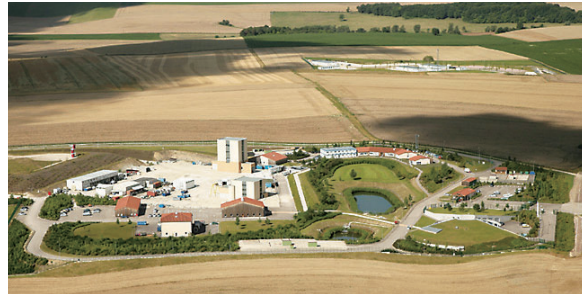
ビュール地下研究所の概観 国際研究の場としても利用されています。 (写真提供 Andra)
