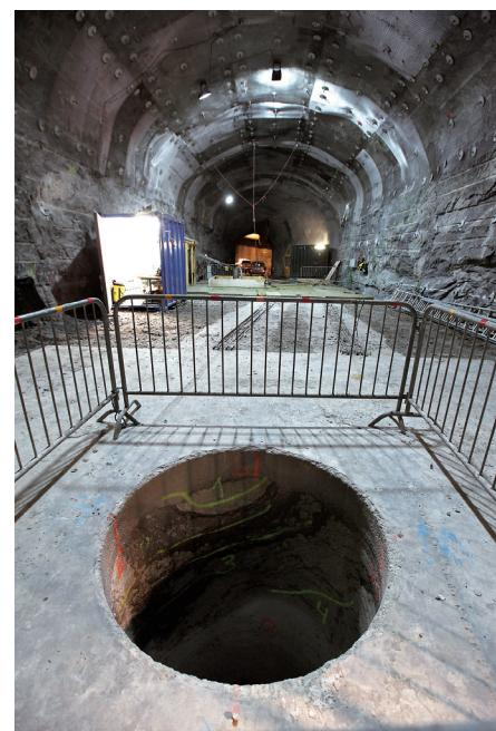
オルキルオトの地下特性調査施設内の坑道と試験処分孔
