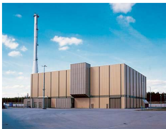
使用済燃料のパイロット・コンディショニング施設 (1999年にゴアレーベンに建設) Pilot-Konditionierungsanlage (PKA)
