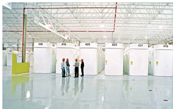
ウェスタン廃棄物管理施設での使用済燃料の乾式貯蔵
