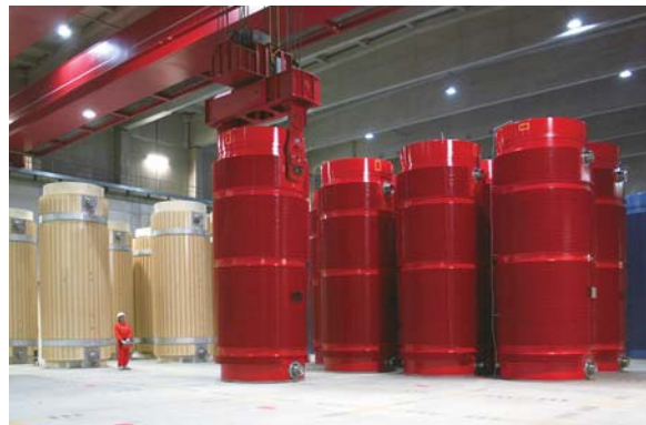
ゴアレーベン中間貯蔵施設における使用済燃料の乾式中間貯蔵
