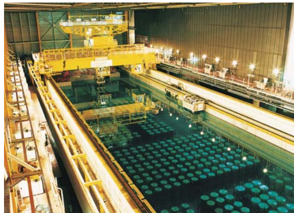
酸化燃料再処理プラント（THORP）内の 使用済燃料貯蔵プール (セラフィールド社ウェブサイトより引用)
