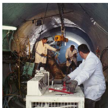
坑道内での調査の様子
