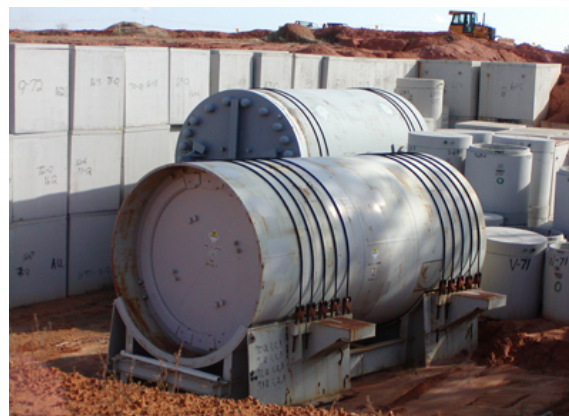
トレンチでの廃棄物定置状況
