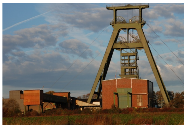
コンラッド処分場の立坑1
