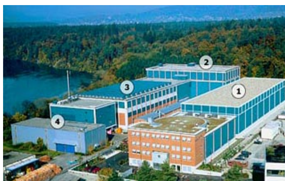
連邦中間貯蔵施設(BZL)(写真の④の建物)
