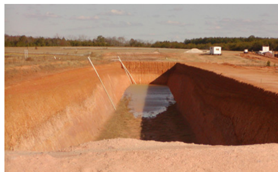
掘削されたトレンチとモニタリング管
