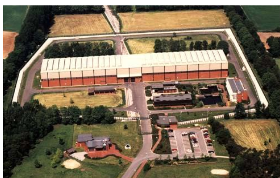
アーハウス中間貯蔵施設の全景
