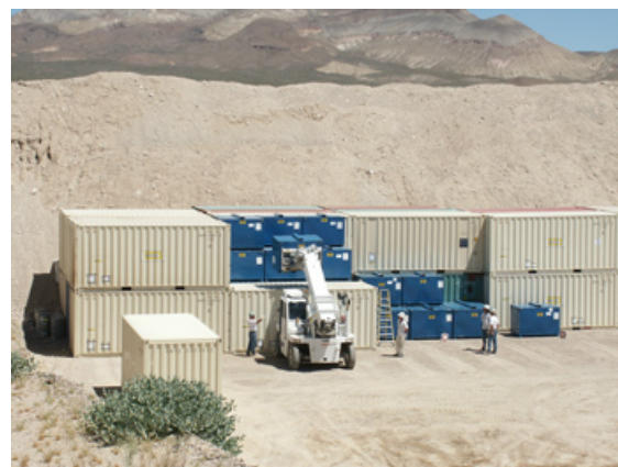
廃棄物セルへの廃棄物の定置作業
