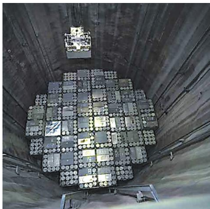
サイロ内での低レベル放射性廃棄物の定置
