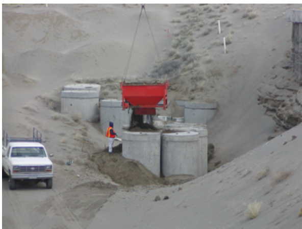
トレンチ処分の状況 (クラス B)
