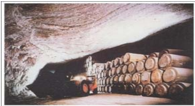
1978年頃のアッセⅡ研究鉱山での 中低レベル放射性廃棄物の定置風景 （DBE社提供）
