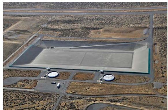
建設が完了した統合処分施設（IDF）
