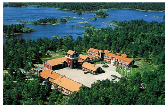
エスポ岩盤研究所の地上部
