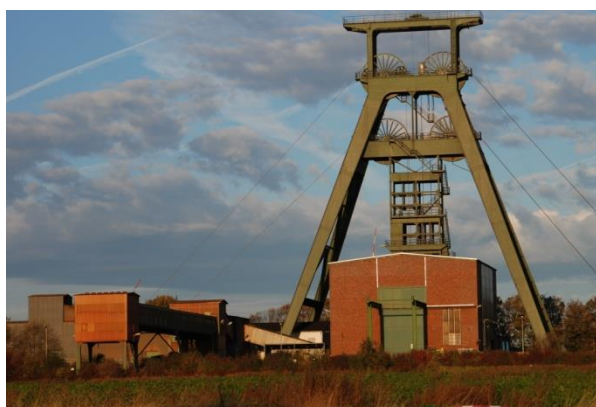
コンラッド処分場の立坑1
