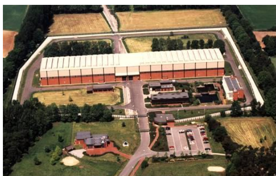
アーハウス中間貯蔵施設の全景
