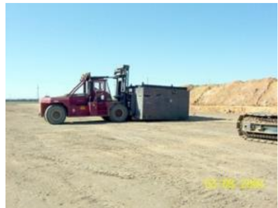
トレンチ処分の状況
