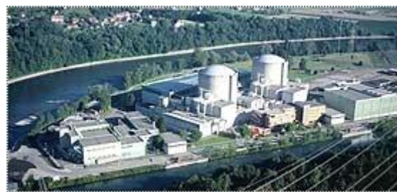
ベツナウ発電所サイト（NOK社ウェブサイトより引用）
