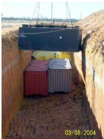
スリット式トレンチ処分（左）と埋め戻し（右）
