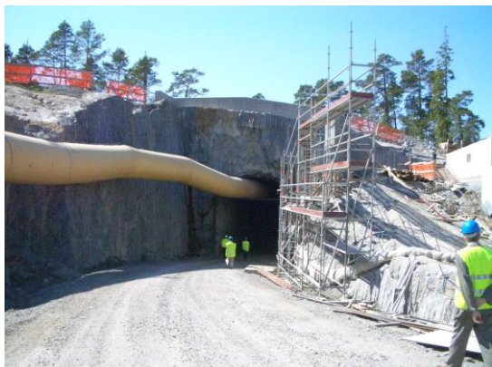
地下特性調査施設（ONKALO）の入口
