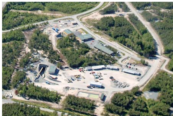
ONKALOの建設状況（2006年夏頃） （ポシヴァ社資料より引用）
