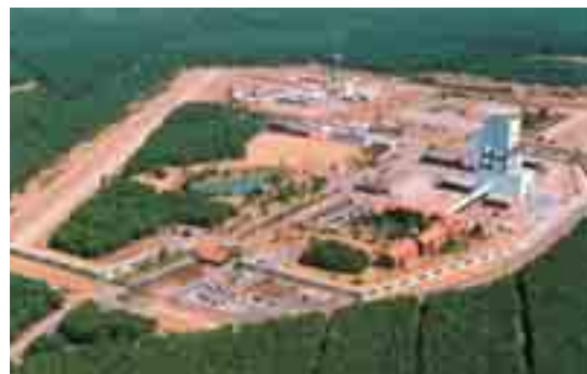
ゴアレーベン施設の全景 (写真提供：DBE)
