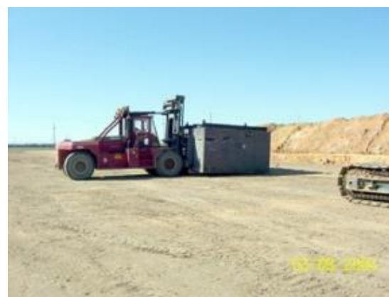
トレンチ処分の状況
