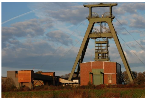
コンラッド処分場の立坑1
