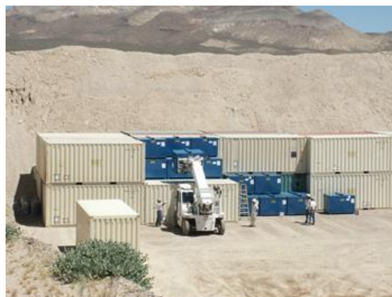
廃棄物セルへの廃棄物の定置作業
