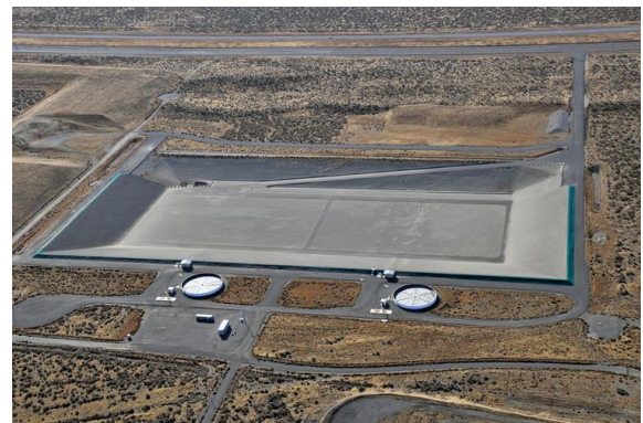
建設が完了した統合処分施設（IDF）
