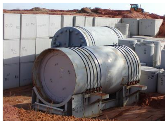
トレンチでの廃棄物定置状況
