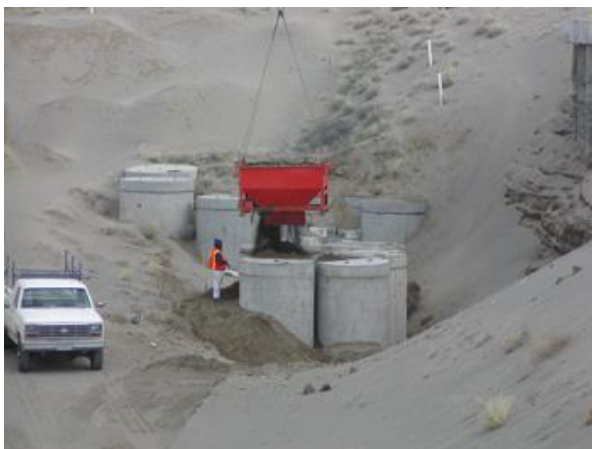
トレンチ処分の状況 (クラス B)
