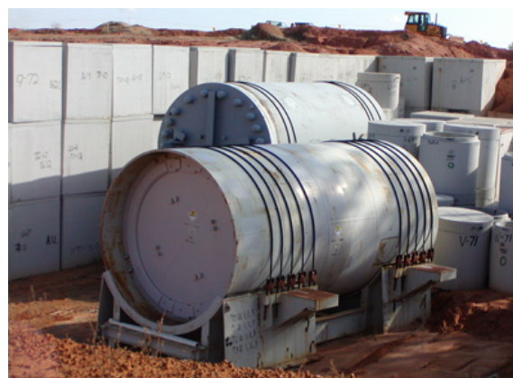
トレンチでの廃棄物定置状況
