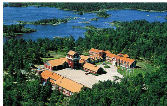
エスポ岩盤研究所の地上部
