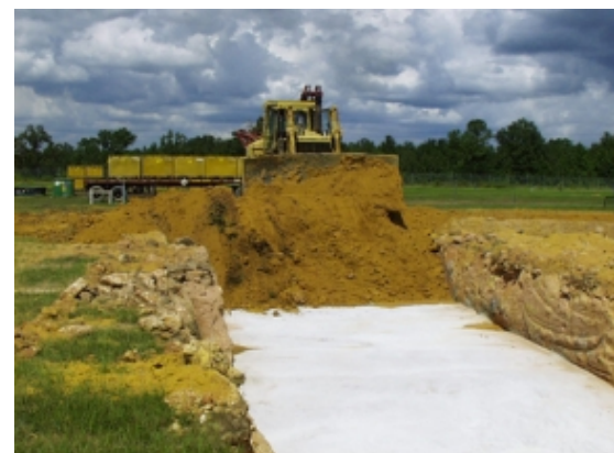
スリット式トレンチ処分（左）と埋め戻し（右）
