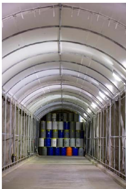
低レベル放射性廃棄物の処分坑道への定置
