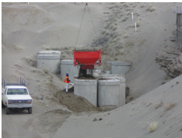
トレンチ処分の状況 (クラス B)
