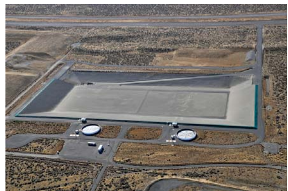
建設が完了した統合処分施設（IDF）
