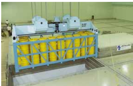
中レベル放射性廃棄物の貯蔵建屋
