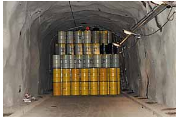
低レベル放射性廃棄物の処分坑道への定置
