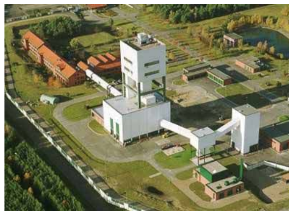
ゴアレーベンの立坑（出典：DBE社）
