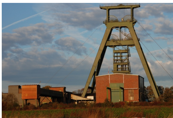
コンラッド処分場の立坑1
