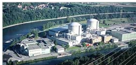
ベツナウ発電所サイト（NOK 社ウェブサイトより引用）
