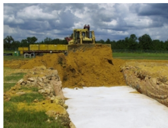
スリット式トレンチ処分（左）と埋め戻し（右）
