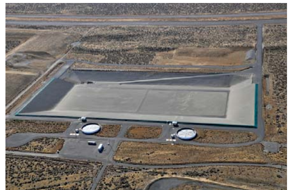
建設が完了した統合処分施設（IDF）
