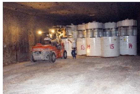
▲ 廃棄物定置状況
