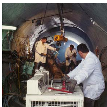
坑道内での調査の様子
