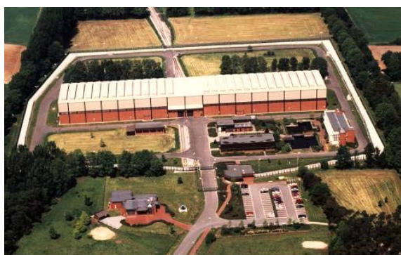
アーハウス中間貯蔵施設の全景
