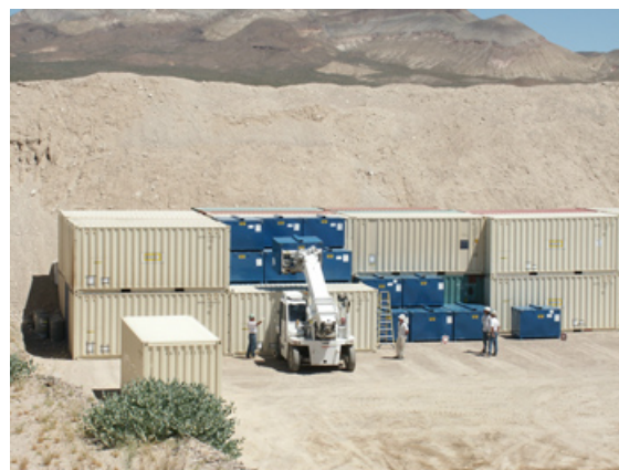
廃棄物セルへの廃棄物の定置作業
