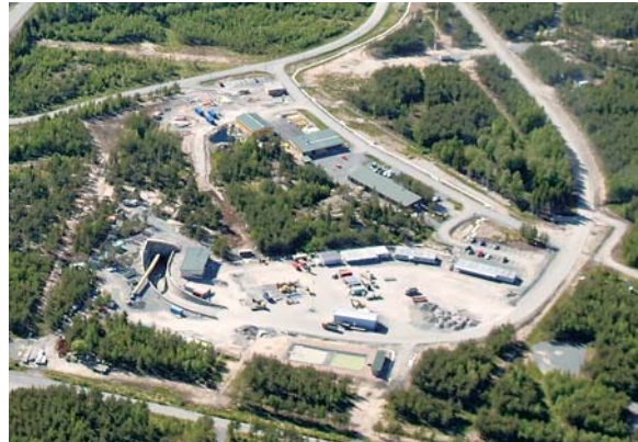
ONKALO®の建設状況（2006年夏頃）
