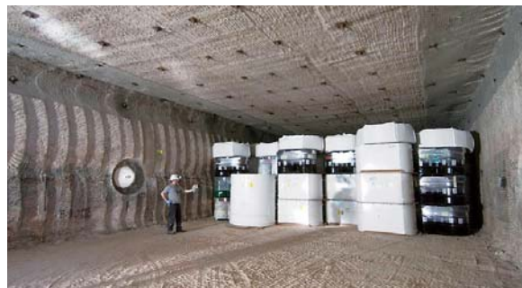
廃棄物隔離パイロットプラント（WIPP）での廃棄物定置状況 （DOE WIPP ウェブサイトより引用）
