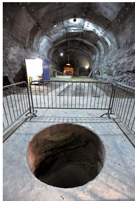
オルキオトの地下特性調査施設内の坑道と試験処分孔
