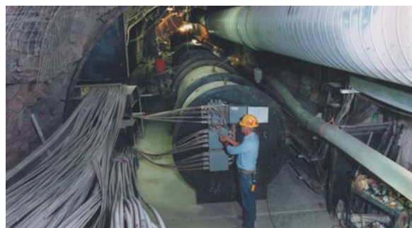
探査研究施設 (ESF) でのヒーターテストの様子 (DOEウェブサイトより引用)
