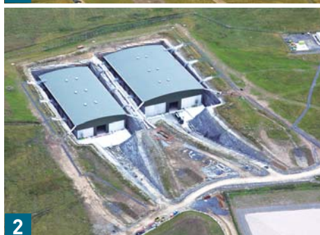
1 ドーンレイサイト (DSRL ウェブサイトより) 2 低レベル放射性廃棄物処分場 (DSRL ウェブサイトより)
