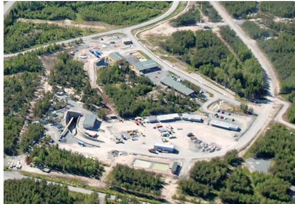
ONKALOの建設状況（2006年夏頃） （ポシヴァ社資料より引用）
