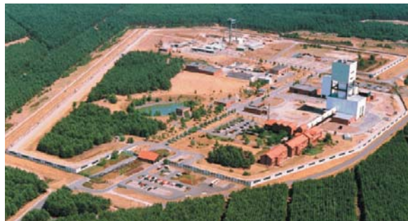
ゴアレーベン施設の全景 (写真提供：DBE)
