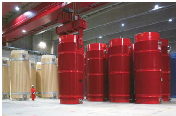
ゴアレーベン中間貯蔵施設における使用済燃料の乾式中間貯蔵
