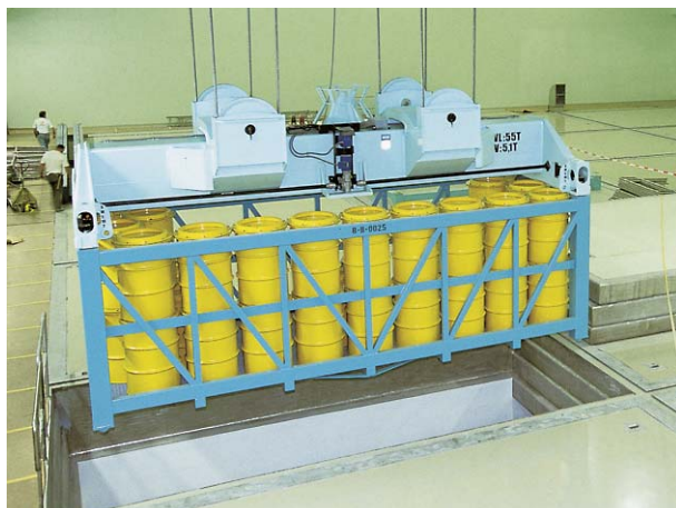
中レベル放射性廃棄物の貯蔵建屋 (上図の3) (NAGRA 提供)
