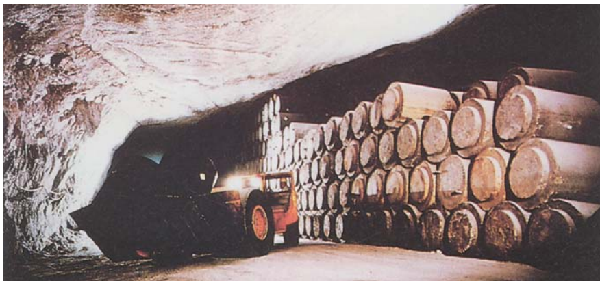
1978年頃のアッセⅡ研究鉱山での低中レベル放射性廃棄物の定置風景 (DBE社提供)
