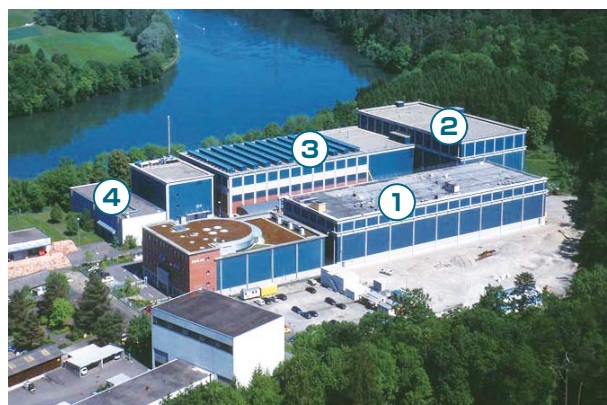
連邦中間貯蔵施設 (BZL) (写真の④の建物) (NAGRA 提供)
