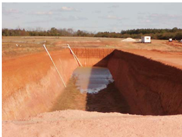
掘削されたトレンチとモニタリング管
