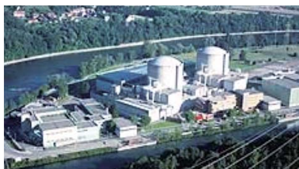
ベツナウ発電所サイト (NOK社ウェブサイトより引用)
