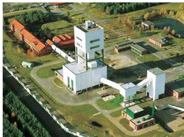
ゴアレーベンの立坑 (DBE社)
