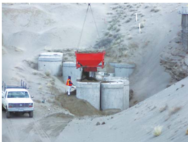
トレンチ処分の状況 (クラスB)
