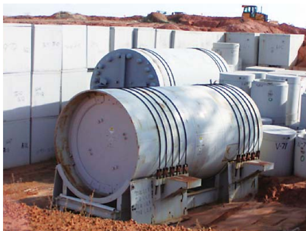
トレンチでの廃棄物定置状況
