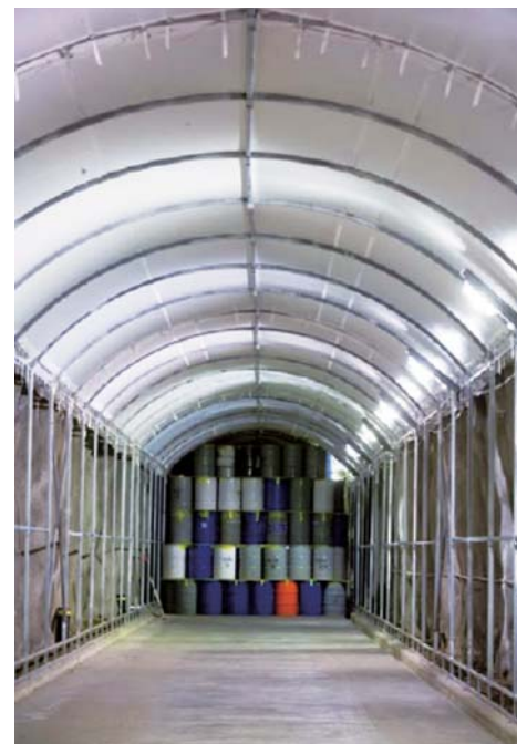
低レベル放射性廃棄物の処分坑道への定置
