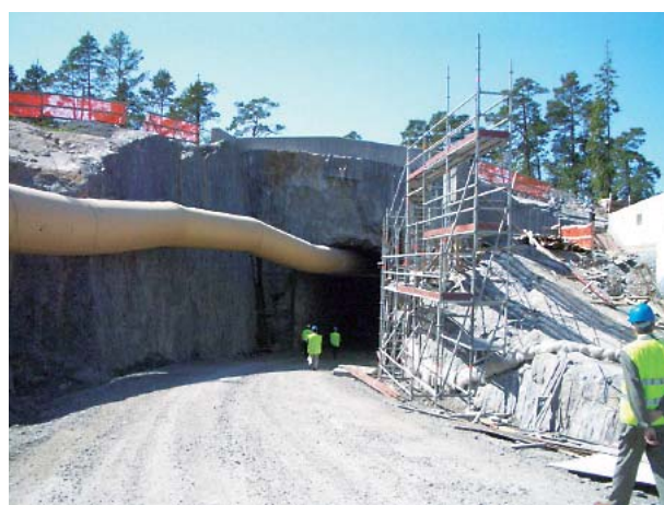
地下特性調査施設 (ONKALO) の入口
