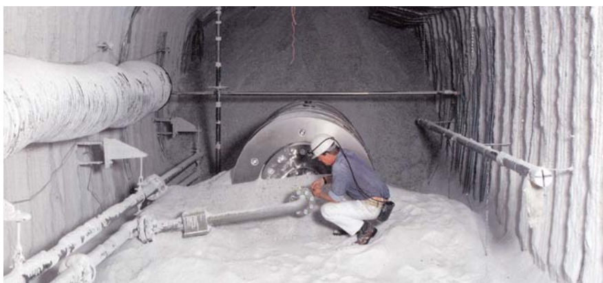
アッセⅡ研究鉱山での直接処分の実験風景 (DBE社提供)
