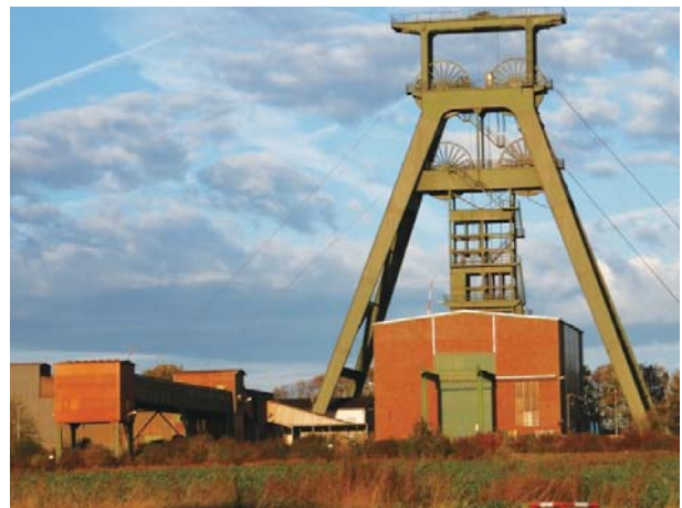
コンラッド処分場の立坑1
