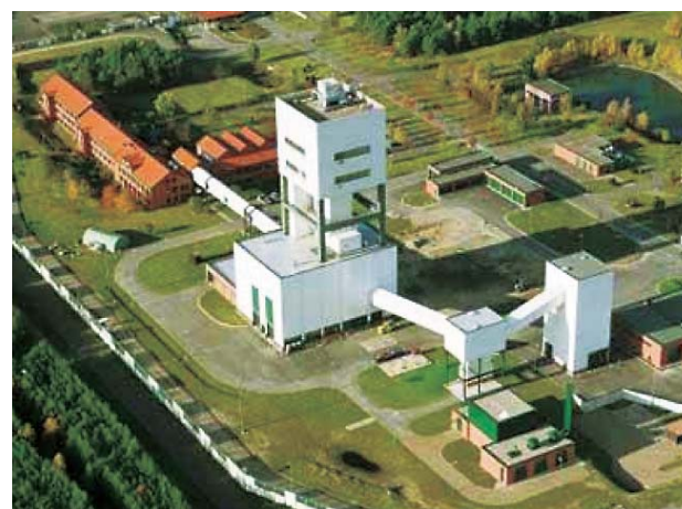
ゴアレーベンの立坑 (DBE社)
