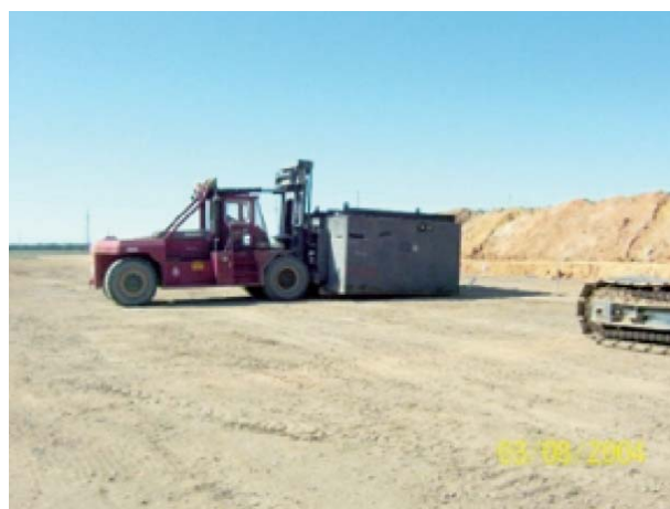
トレンチ処分の状況 (DOEウェブサイトより引用)
