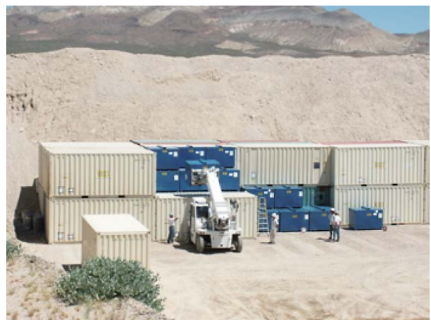
廃棄物セルへの廃棄物の定置作業 (DOEウェブサイトより引用)
