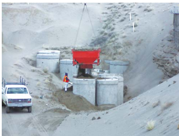
トレンチ処分の状況 (クラスB)
