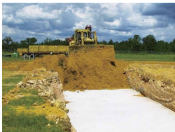
スリット式トレンチ処分(左) と埋め戻し(右) (DOEウェブサイトより引用)
