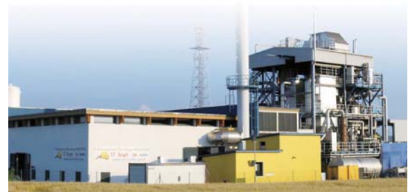
廃棄物発生者による地域振興事業例 (木材ガス化プラント) (EDF報告書より引用)
